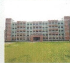
টেক স্ক্রিপশন হার্বিক্সেট আবাসিক ভবন, টাঙ্গাইল
